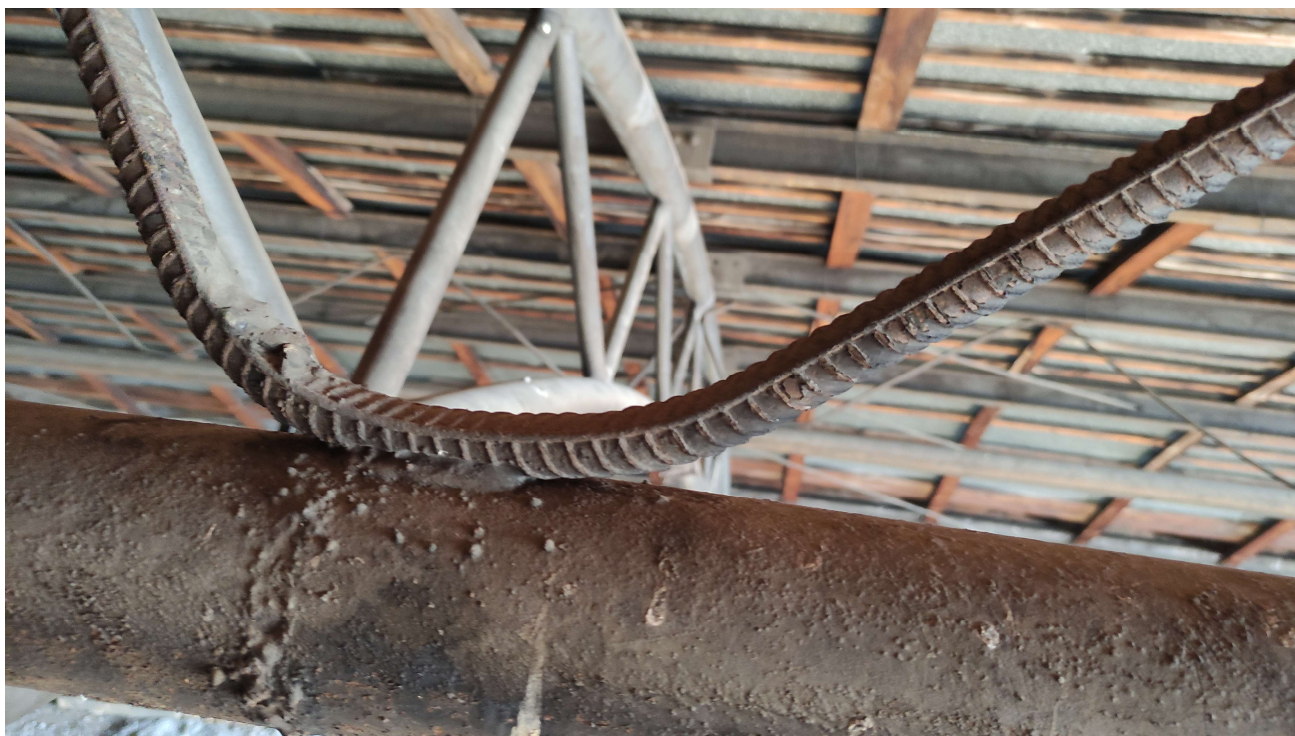
Foto č.9 – pohled na styčník diagonály podélného ztužení a dolního pasu příhradového podélného ztužidla
