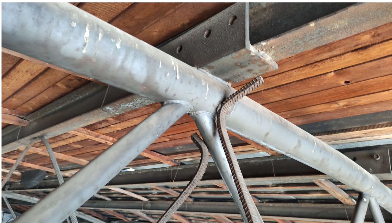
Foto č.7 – pohled na uložení vaznice na oblouk (patrné konstrukčně a staticky nevhodné připojení diagonál podélného ztužení na oblouk)
